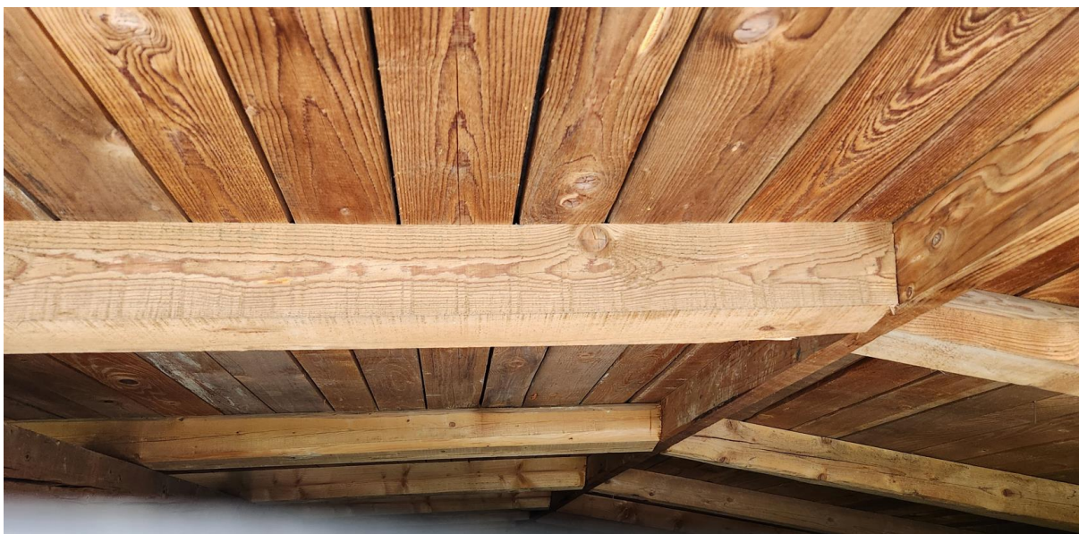
Slika 2 - Obstojече leseno ostrešje (Vir: Rejec, 2024)
